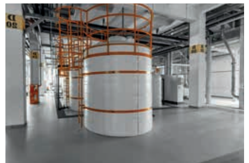
Beton hersteld en vloer gecoat. Tevens hebben we de GRP looproosters van de afwateringskanalen geproduceerd en gemonteerd / Le béton a été réparé et le sol revêtu. Nous avons également produit et installé les caillebotis en GRP pour les canaux de drainage.
