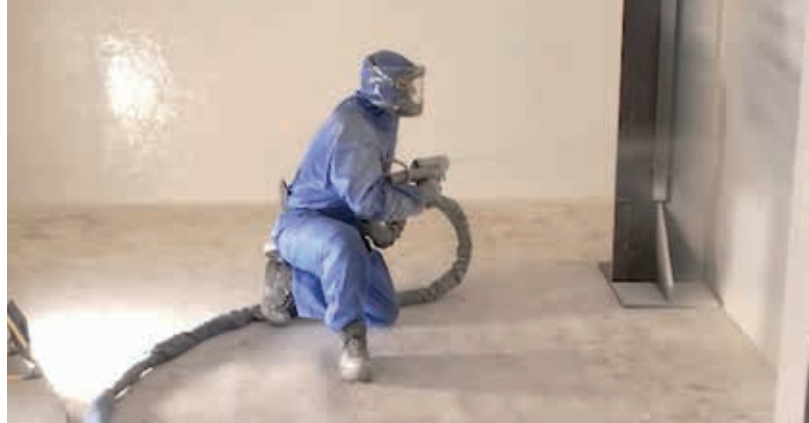
Aanbrengen van poly-urea spuitcoatings om ruimtes vloeistofdicht te maken / Application de revêtements par pulvérisation de polyurée pour rendre les espaces imperméables aux liquides
